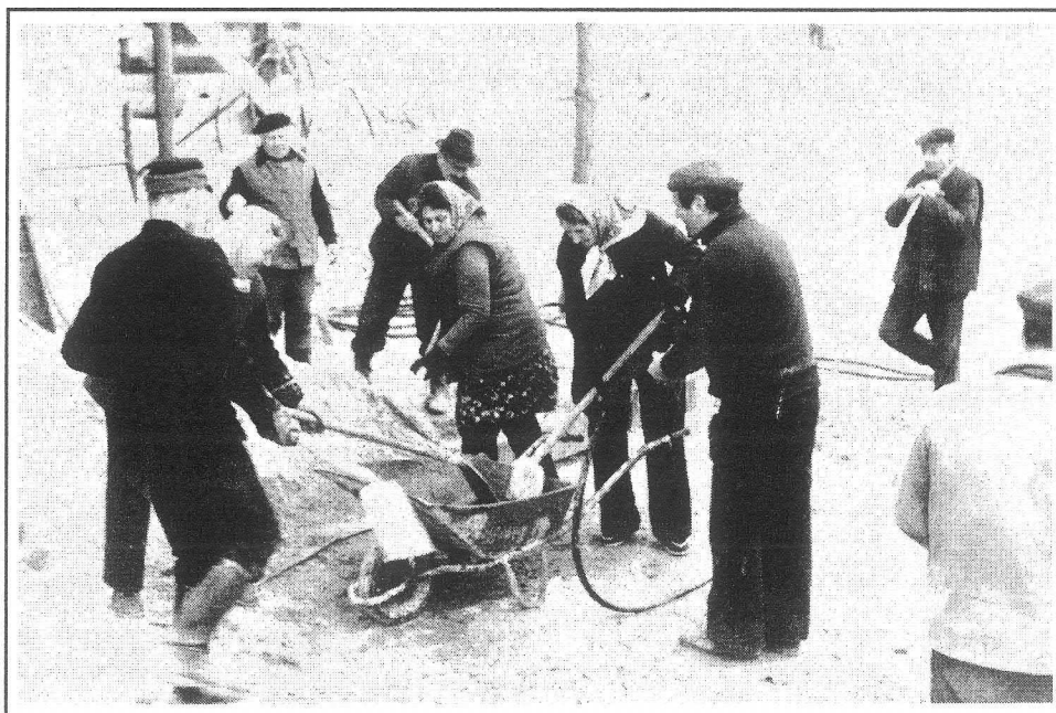
Rozpoczęcie prac przy budowie kaplicy
